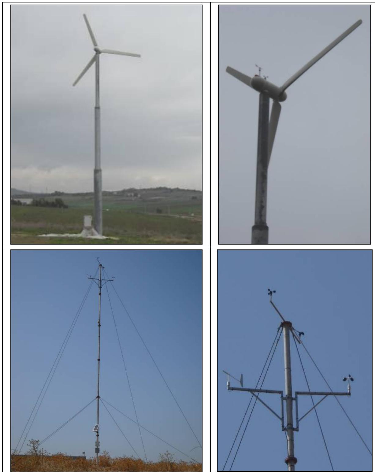
**Fig. 5.14 – Miniaerogeneratore da 10 kW e torre anemometrica installati a Favara, con visibili i vecchi e i nuovi sensori del vento, questi ultimi disposti a quota inferiore.**
