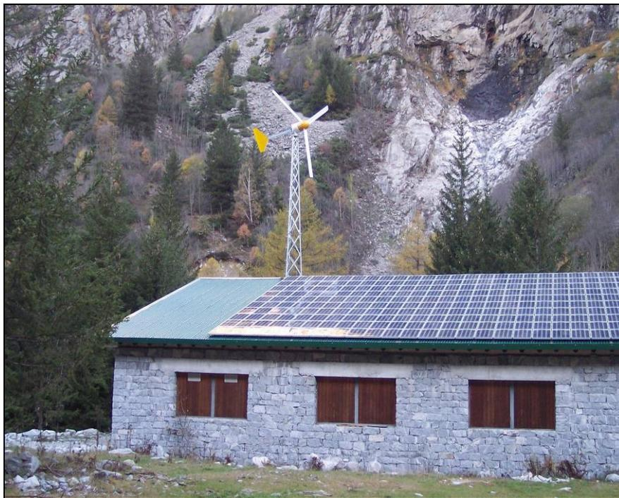
**Fig. 5.16 – Edificio nella località Bresciadega, in Val Codera, dove sono installati diversi sistemi di generazione (tra i quali uno fotovoltaico da 14 kWp sul tetto e uno minieolico da 10 kW nel cortile) per alimentare un impianto ad isola predisposto per fornire corrente elettrica a 15 abitazioni.**
