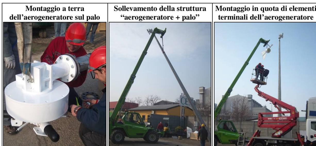
**Fig. 4.4 – Operazioni d'installazione dell'aerogeneratore presso RSE.**
