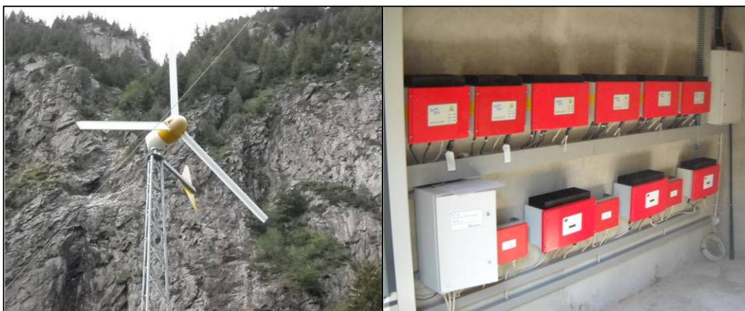
**Fig. 5.18 – Miniaerogeneratore BWC EXCEL S/50 da 10 kW e parte del sistema di gestione dell’impianto minieolico; in particolare i tre contenitori rossi più piccoli della foto a destra sono inverter SMA Wind Boy WB1200.**
