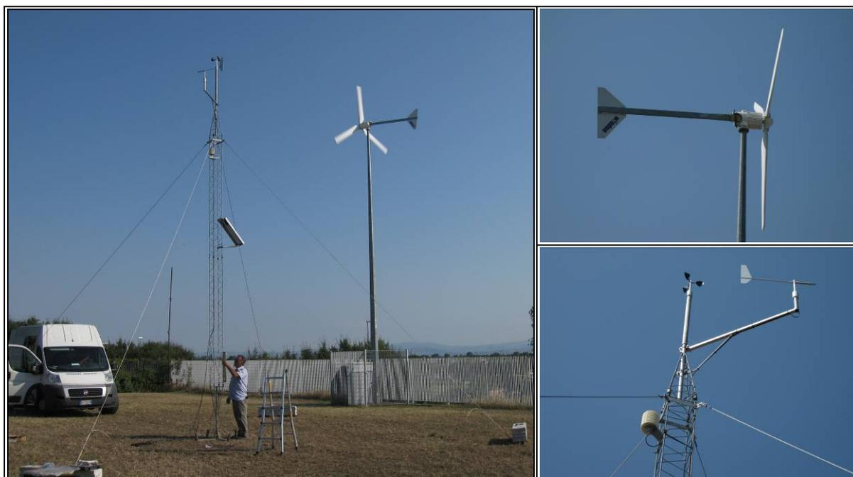
**Fig. 5.5 – Miniaerogeneratore da 2 kW e torre anemometrica installati a Cesenatico.**
