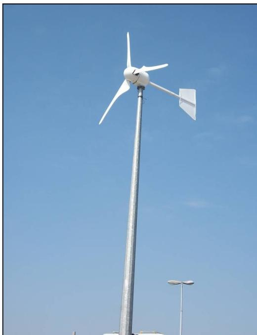
L'aerogeneratore Mistral con rotore tripala del diametro di 4 m facente parte dell'impianto minieolico da 3 kW installato da RSE presso la propria sede di Milano.
